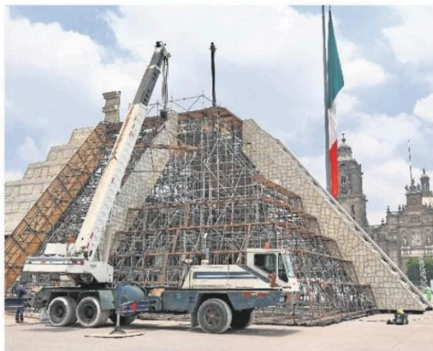
El retiro de la estructura se realiza a través de dos grúas de movilidad, una de 10 metros de altura y otra de siete.
